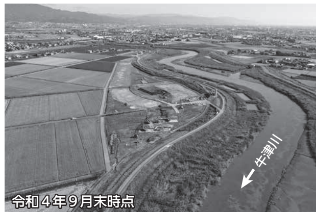
堤防整備状況
